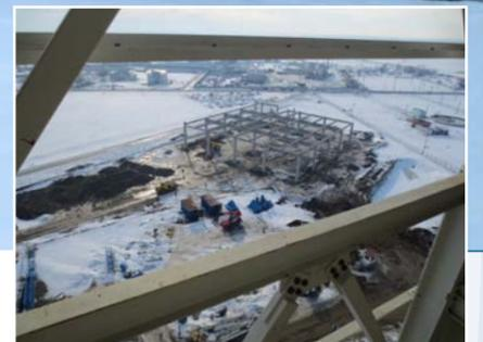
BT-Anlagenbau hat mit Ende März eine der extremsten Baustellen der letzten Zeit fertiggestellt. Bei  $-20^{\circ}\text{C}$  waren bis zu 20 Elektrotechniker in der Trockenmörtelmischanlage in Rumänien beschäftigt, um unter anderem Kabel zu verlegen, eine NSHV-Anlage zu montieren und mehr als 20 I/O-Stationen (RIOs) für die Sensorik zu installieren.
